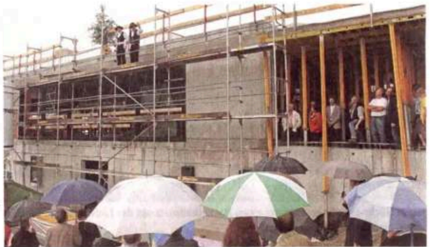
Gleich für zwei Gebäude wurde Hebauf gefeiert: für die neue Dreifachturnhalle (unser Bild) und den Umbau der alten.
