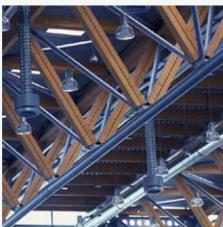
Oben und unten: BS-Holz-Konstruktionen können nicht nur gewaltige Ausmaße annehmen, sondern auch problemlos mit anderen Materialien kombiniert werden. FOTOS: WELLER (2), STEPHAN
