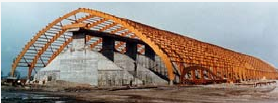
Oben und unten: BS-Holz-Konstruktionen können nicht nur gewaltige Ausmaße annehmen, sondern auch problemlos mit anderen Materialien kombiniert werden. FOTOS: WELLER (2), STEPHAN
