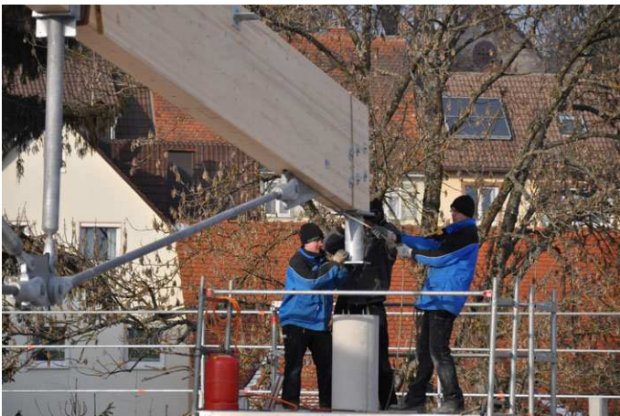
(Bild 4 – Montage Pfeiler)
