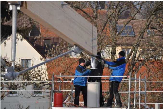
(Bild 4 – Montage Pfeiler)
